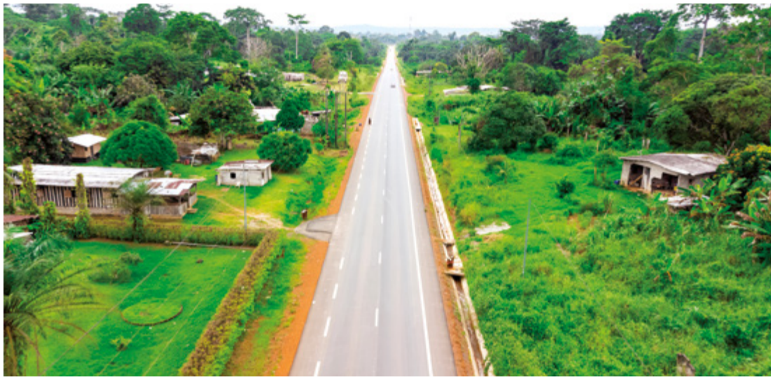
La concession du tronçon du PK12 au PK105 oblige Meridiam au travers de la SAG à maintenir pendant 30 ans la route dans un état neuf.
