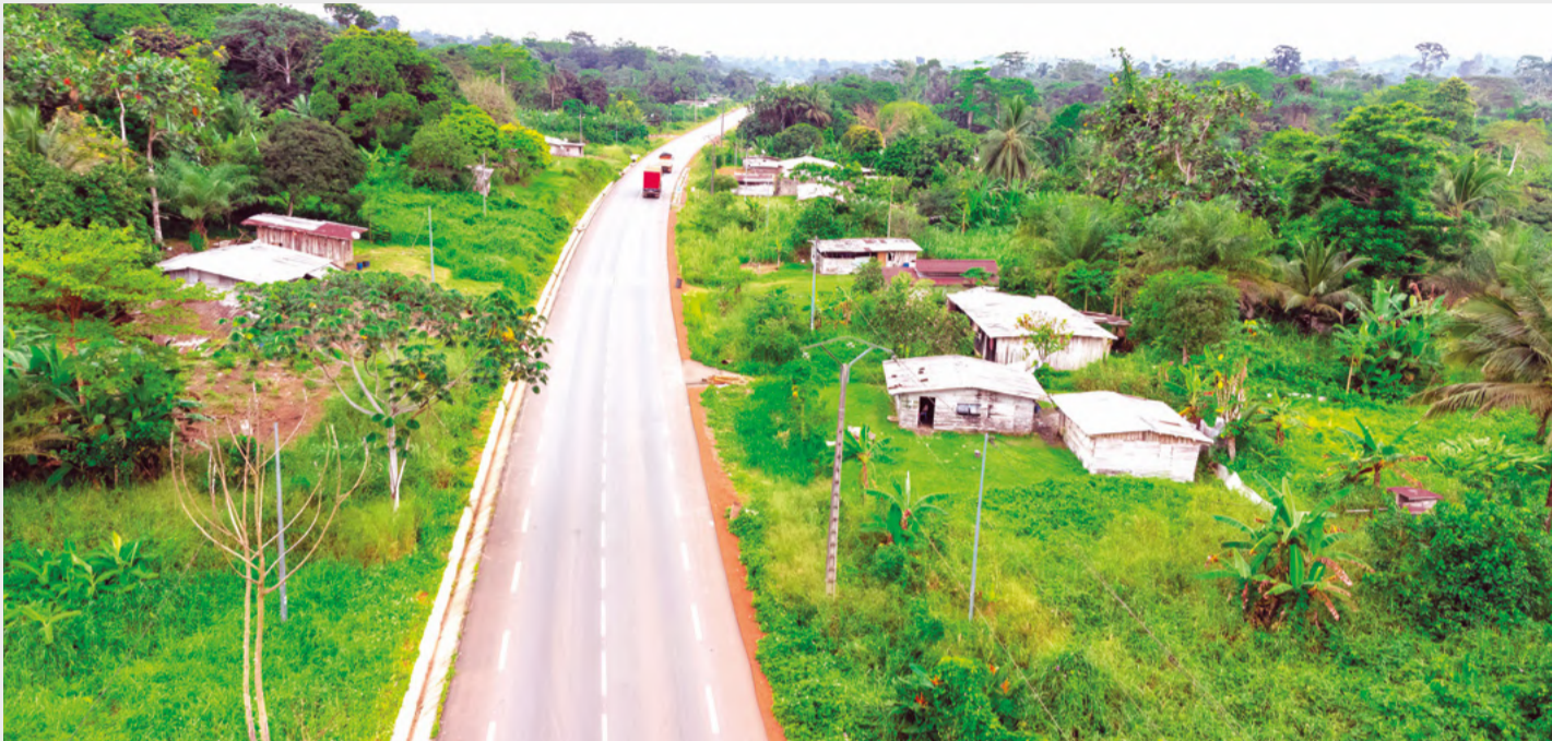
Vue aérienne d'une partie du tronçon de la RN1 réhabilitée.
