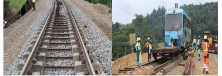
●●● Opération de pose de voie
