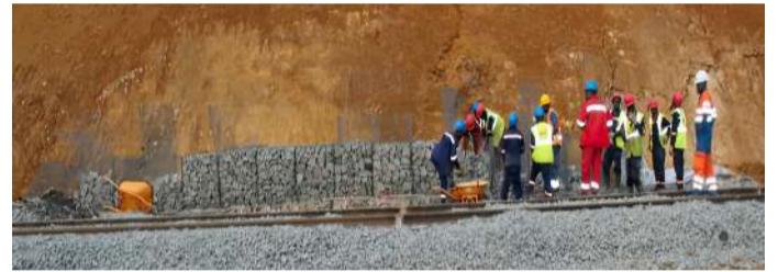
●●● Pose de cages à gabion
