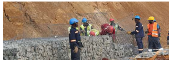
●●● Poursuite des travaux de décaissement sur le talus
