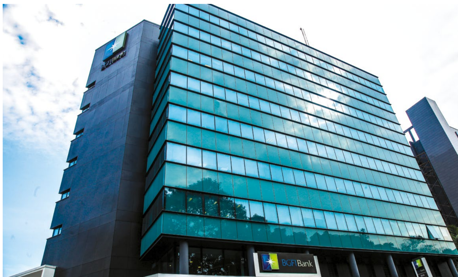
Siège Social et Direction Générale de BGFIBank Congo-Brazzaville
